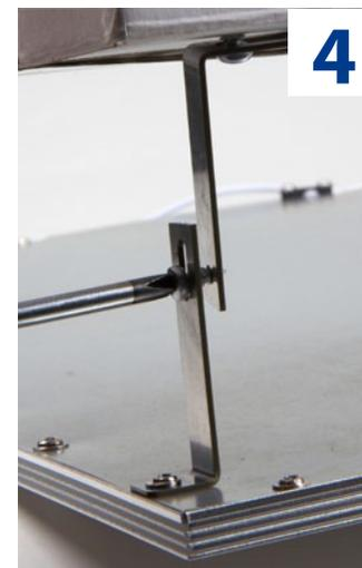
**Соединить и закрепить малым шурупом из комплекта поставки крепежные уголки на панели и потолке.**
